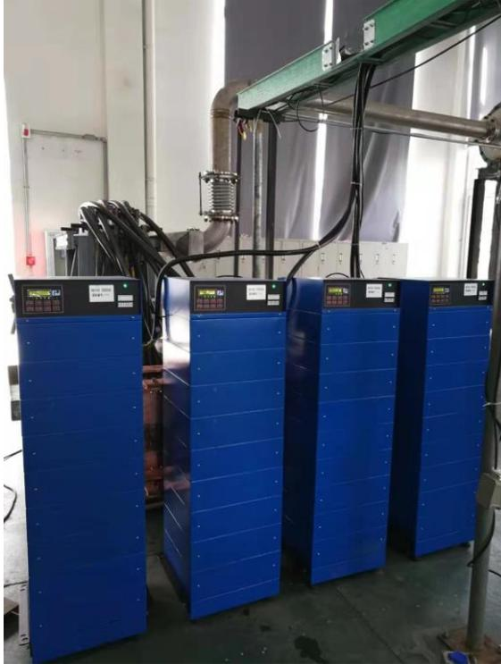
B: 风冷型 DC16V15000A: 山东某钢铁厂
